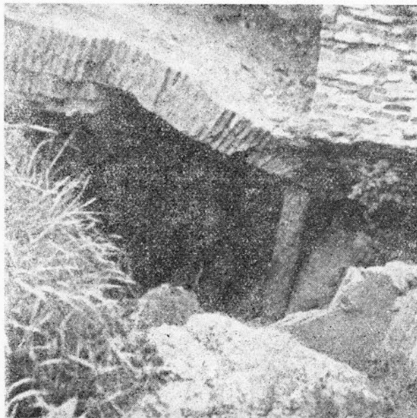
L'entrée du chantier n° 2.
