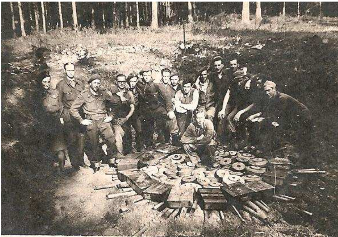
Photo d'archive : préparation d'un puits de destruction dans les bois de VIELSALM en septembre 1945 (1Bn Déminage – 5ème Cie) - Don d'André Vanhelmont (4ème en partant de la gauche)
