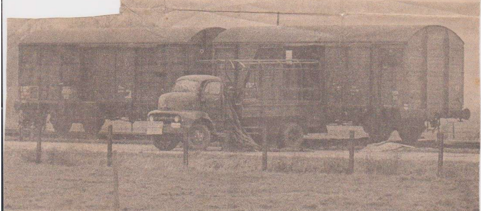
De plaats van de ramp te Westrozebeke: de twee spoorwagens met de vrachtwagen, waarvan het zeildoek helemaal weggerukt is. Ogenschijnlijk is er weinig schade, maar toch vielen er één dode en zes gewonden te betreuren.
