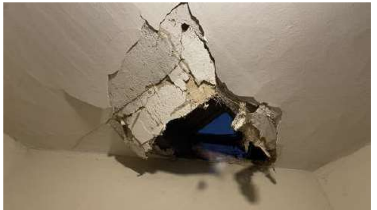
Op de plaats waar het explosief is afgestaan, gaapt een groot gat in de vloer. © BFM
