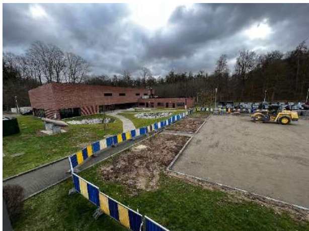
zicht op blok 60 en de uitbreiding van de parking vue du bloc 60 et de l'agrandissement du parking
