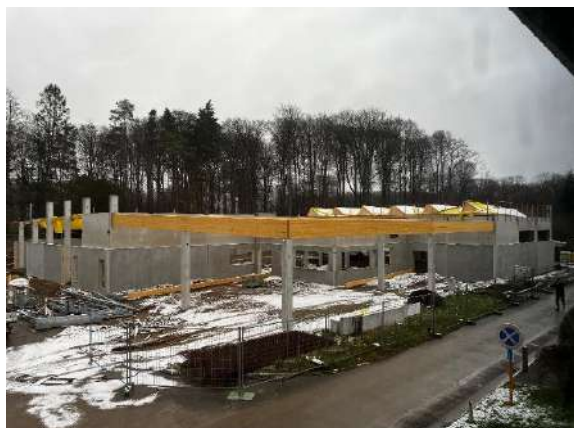
Werk van de nieuwe didactische zaal Construction de la nouvelle salle didactique
